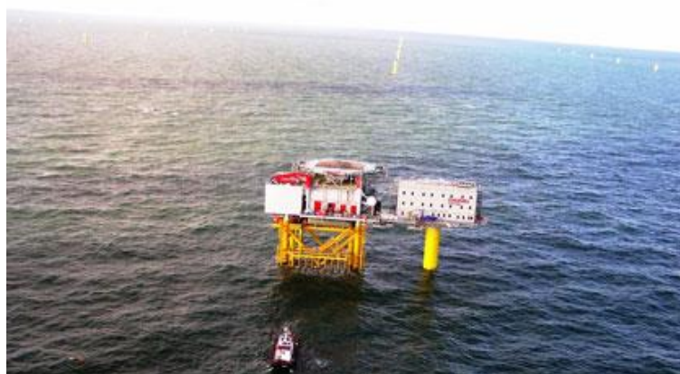
Fotografia 2. Platforma mieszkalna Horns Rev 2, po zainstalowaniu w sąsiedztwie stacji elektroenergetycznej
